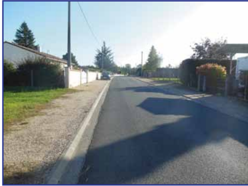
Canalisation enterrée sur rue de la Fragnée (à gauche la zone 1AU d'Augereau Sud)
