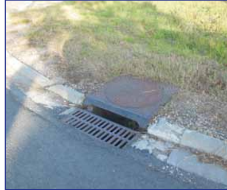
Avaloir dans la partie aval de la rue de la Fragnée
